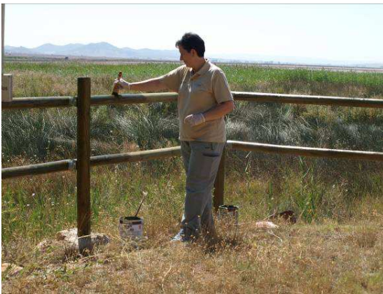
Mantenimiento de los vallados de los observatorios
