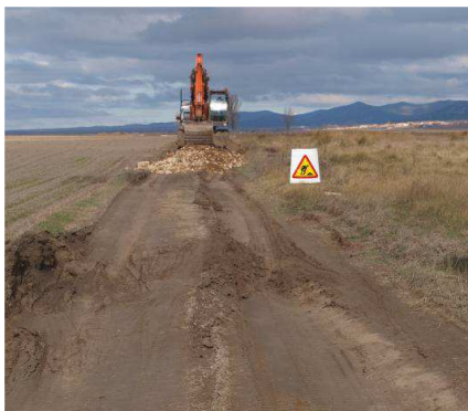
Excavadora trabajando en el camino
