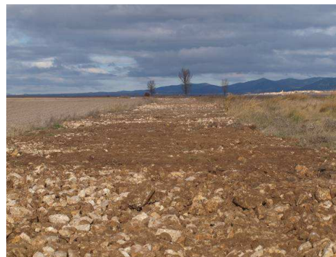
Pedraplén en el camino
