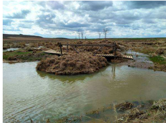
Acumulación de capitanas que los vigilantes retiraron
