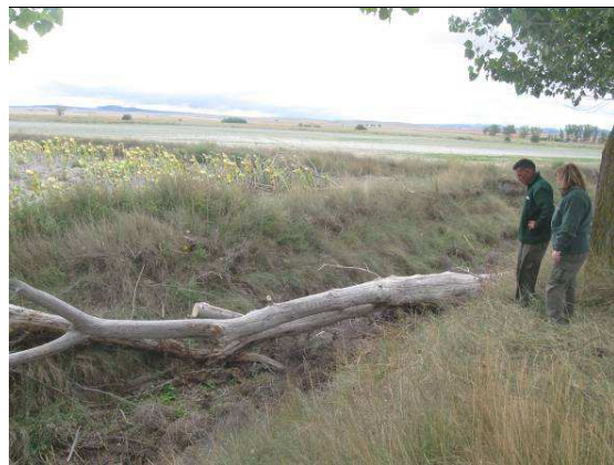
Trocear y retirada de troncos de acequia
