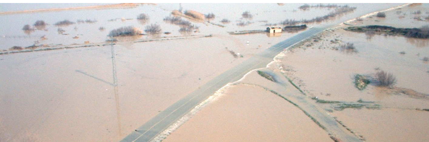
Carreteras y campos de cultivo anegados por la avenida del río Ebro. Se aprecia el efecto dique que origina la carretera
