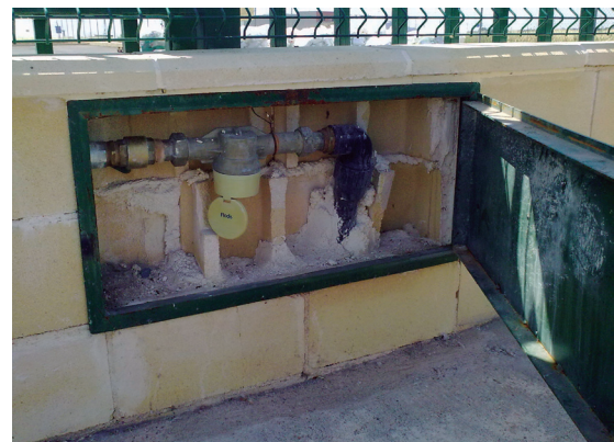
El contador está tan alto que para poder leerlo se ha instalado boca abajo. Pérdida de precisión.
