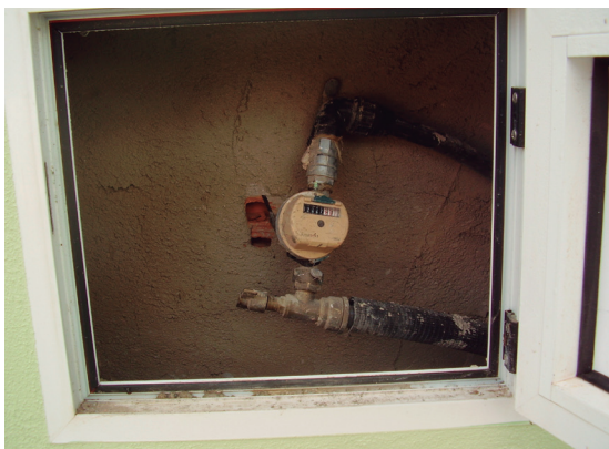
Contador de velocidad en posición vertical. Se reduce la precisión metrológica del equipo.
