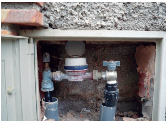
Contador excesivamente alto. Dificultad para leer el totalizador.
