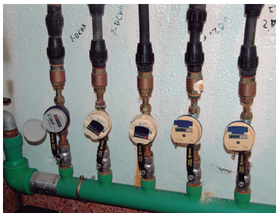
Batería instalada en vertical.
