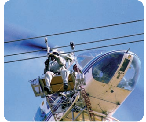
Colocación manual de balizas salvapájaros espirales en los cables de tierra mediante helicóptero.
