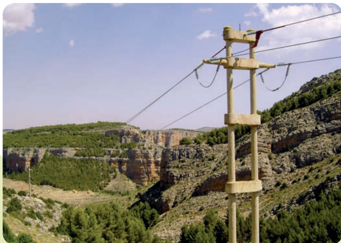
Puentes flojos suspendidos y conductores aislados en la Línea de Campillo a Calmarza (15 Kv) dentro de la ZEPA de las Hoces del Río Mesa
