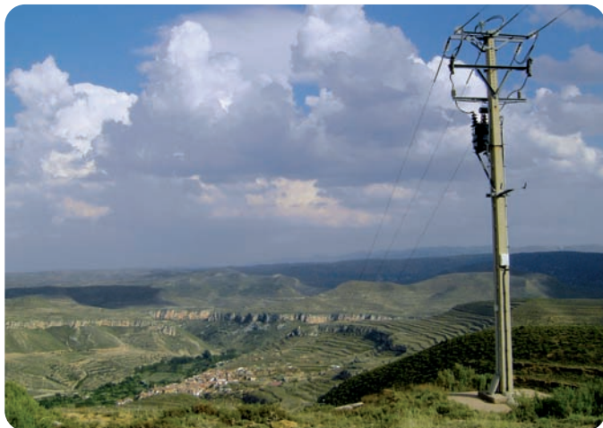
Aislamiento de puente flojo, bajantes y conductores en la Línea de Josa a Obón (15 Kv) en la ZEPA de los desfiladeros del Río Martín
