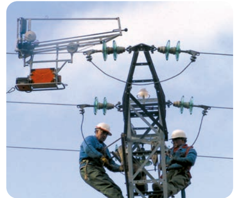
Colocación de balizas salvapájaros "X" de neopreno en los cables conductores mediante robot guiado.
