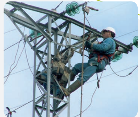
Corrección de apoyos para evitar accidentes por electrocución
