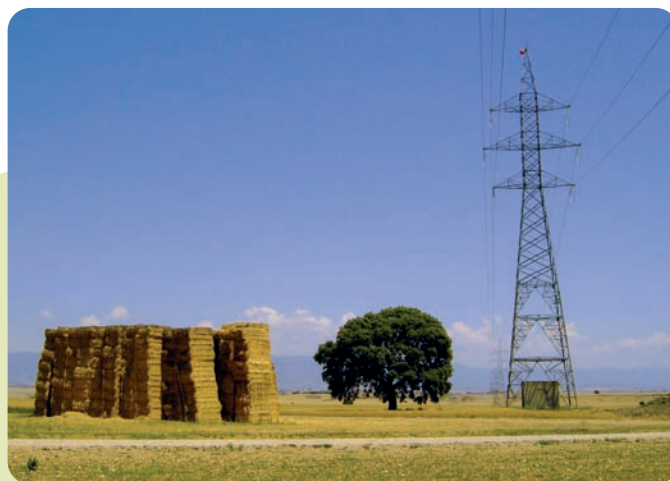
Señalización del cable de tierra en la Línea de Sabiñánigo a Gurrea (220 Kv) dentro de la ZEPA del Embalse de La Sotenera
