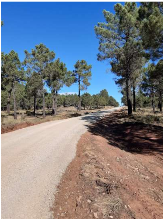
Pista forestal con nuevo firme y limpieza de cunetas
