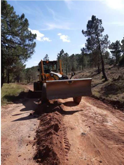
Motoniveladora trabajando en la pista forestal
