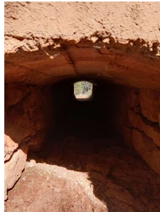
Limpeza de paso de agua
