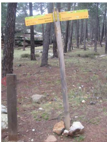
Señal direccional no anclada al firme. ANTES
