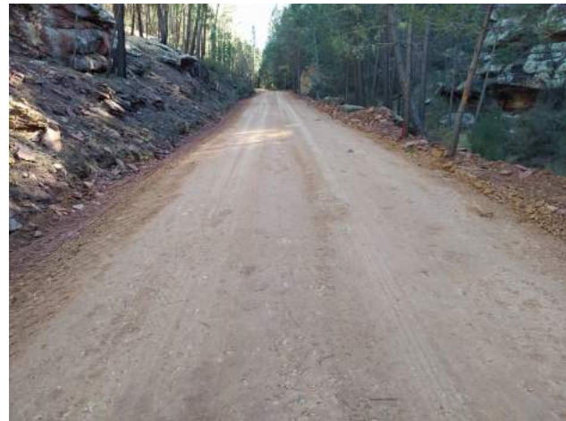
Estado del firme después de los trabajos
