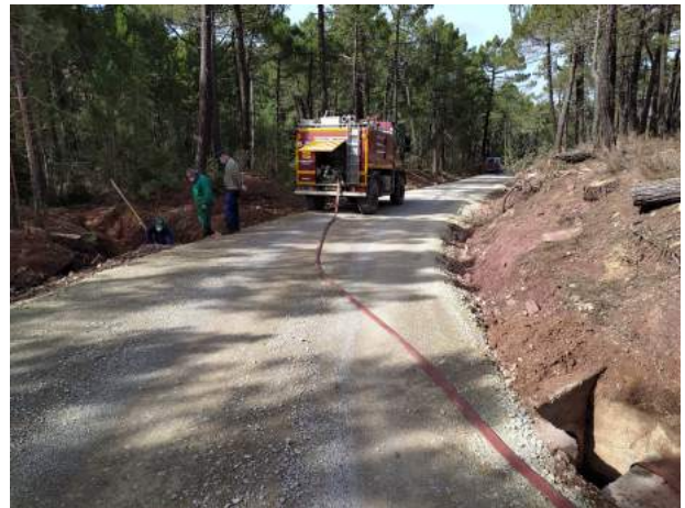
Limpieza de pasos de agua con ayuda de la motobomba
