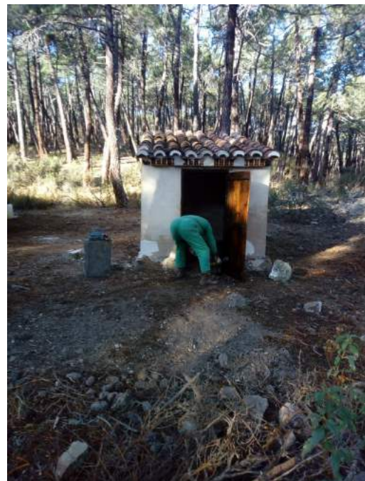
Arreglo de antiguo caseto de resineros en Bezas
