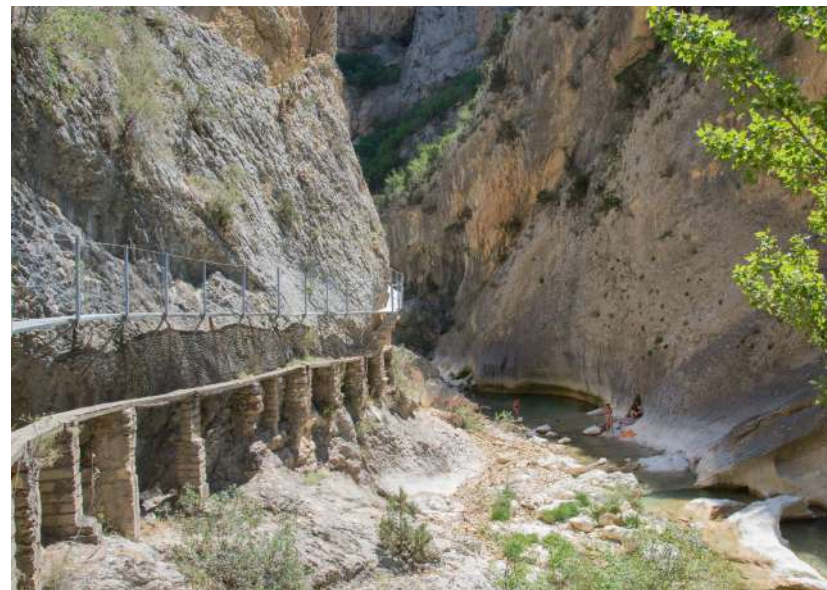
Pasarelas de Alquezar
