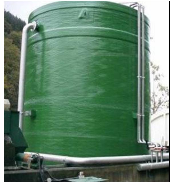
Reactor MBBR circular prefabricado
