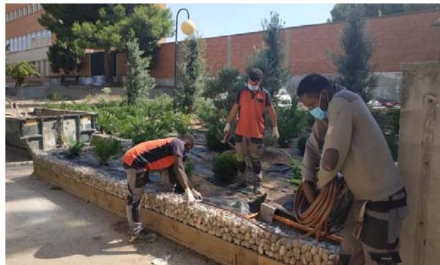
**JARDIN PUERTA LIMONES. Aspectos trabajados:** Construcción de jardinera con la instalación de traviesas y gaviones, relleno y preparación con tierra vegetal, plantación de arbustos y grande ejemplares ( olivos 5 de alturas de 4 mts) y la instalación de riego, malla anti hierba y grava)
