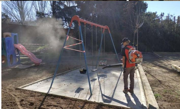
**RESTAURACION Y MANTENIMIENTO DE COLUMPIOS METALICOS LIJADO – PINTURA EFECTO MADERA – PROTECTOR DEL SUELO DE CAUCHO Y LIMPIEZA DEL SUELO TECNICO.**
