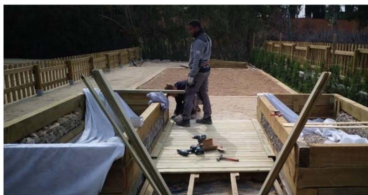
**DELIMITACION DE LA ZONA DE HUERTO CON LA INSTALACION DE BORDILLOS Y TRAVIASAS DE MADERA. (REPLANTEO - ENCOFRADO - VERTIDO DE HORMIGON - INSTALACION DE TRAVIASAS DE MADERA- VALLADO PERIMETRAL DE 1 M - CONSTRUCCION DE JARDINERAS- CONSTRUCCION DE TARIMA PARA PERSONAS DE REDUCCION LIMITADA Y CALCULO E INSTALACION DE RIEGO GENERAL )**
