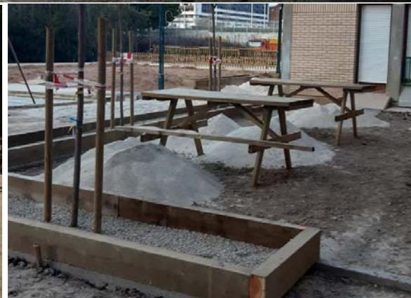
**ZONIFICACION DE ZONA PIC - NIC** CON LA INSTALACION DE BORDILLOS Y TRAVIESAS DE MADERA. (REPLANTEO - ENCOFRADO – VERTIDO DE HORMIGON – INSTALACION DE TRAVIESAS DE MADERA- INSTALACION DE JARDINERA CON DOBLE RIEGO PARA ARBOLES Y ARBUSTOS –
