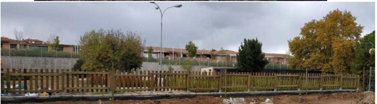
**CONSTRUCCION DE MURO DE HORMIGON PARA INSTALACION DE VALLADO DE MADERA. –REPLANTEO – ENCOFRADO Y VERTIDO DE HORMIGON DE SOLERA - COLOCACION DE BLOQUES DE HORMIGON – ENFOCADO – AISLAMIENTO DEL MURO E INSTALCION DEL VALLADO DE MADERA.**
