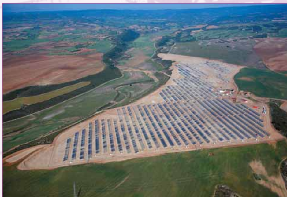
Instalación solar de 9 MW con seguidor a 1 eje. Zuera (Zaragoza).
