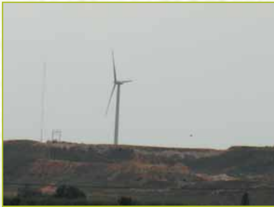
Aerogenerador anexo a Central Hidroeléctrica Villa de los Angeles (Quinto de Ebro).
