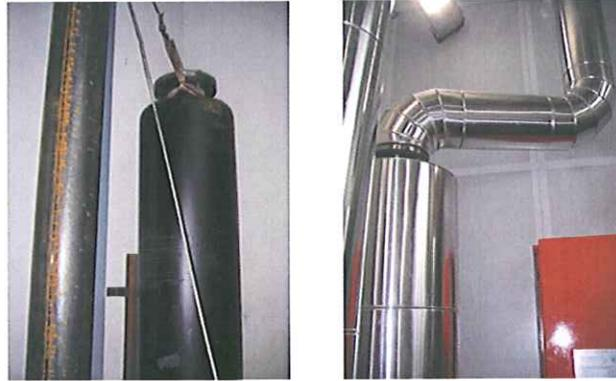
Silencioso de escape y salida a exterior (instalación y estado final)
