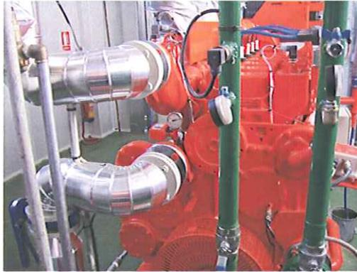
Tuberías de entrada y salida a motor de circuitos refrigeración principal y secundario
