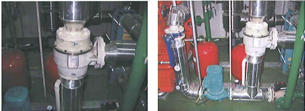
Caja válvulas termostáticas dispuesta para poder desviar agua directamente a motor
