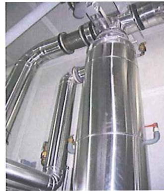
Intercambiador gases de escape y válvula de tres vías de gases de escape
