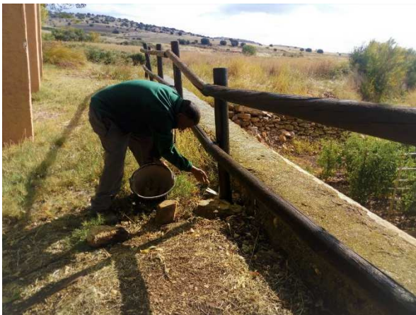
Mantenimiento de vallados
