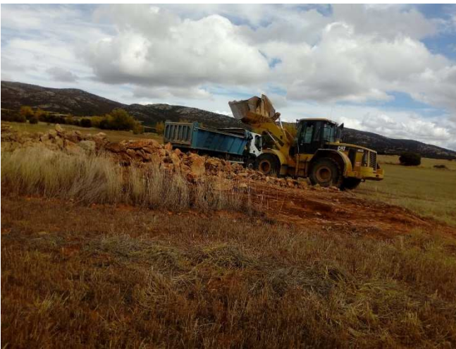
Camión y cargador trabajando en las obras del camino
