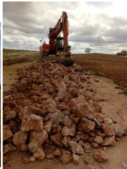
Retro ejecutando el pedraplén
