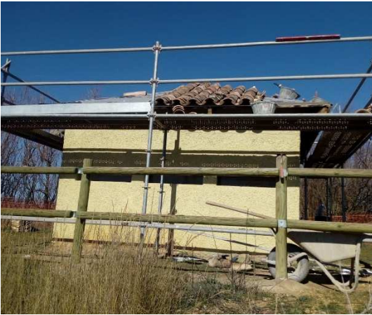
Obras en la cubierta del observatorio
