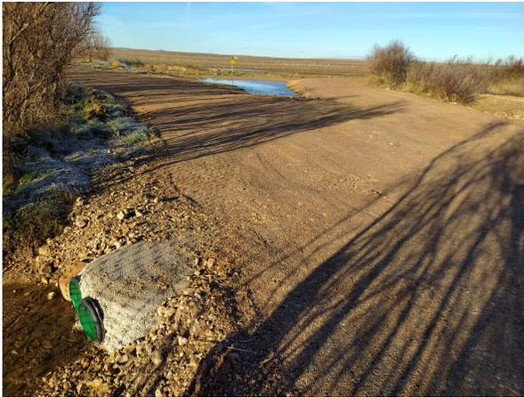
Drenaje con 2 tubos y elevación de la pista en Aguanares
