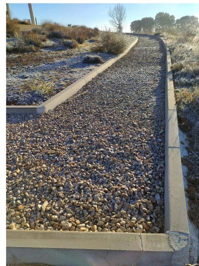
Conexión con bordillo de hormigón y firme de grava
