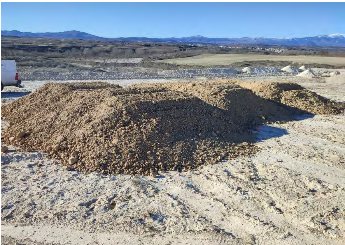
Fotografía 2. Acopio de tierra vegetal.
