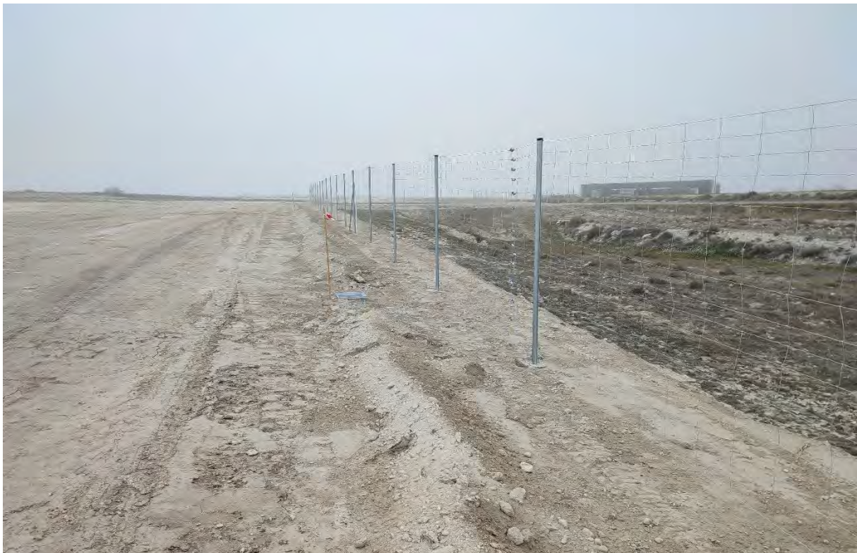
Fotografía 8. Vallado cinegético perimetral
