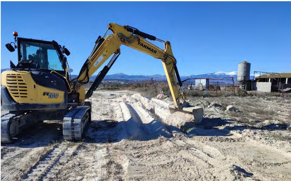
Fotografía 4. Tapado de zanjas con retroexcavadora.
