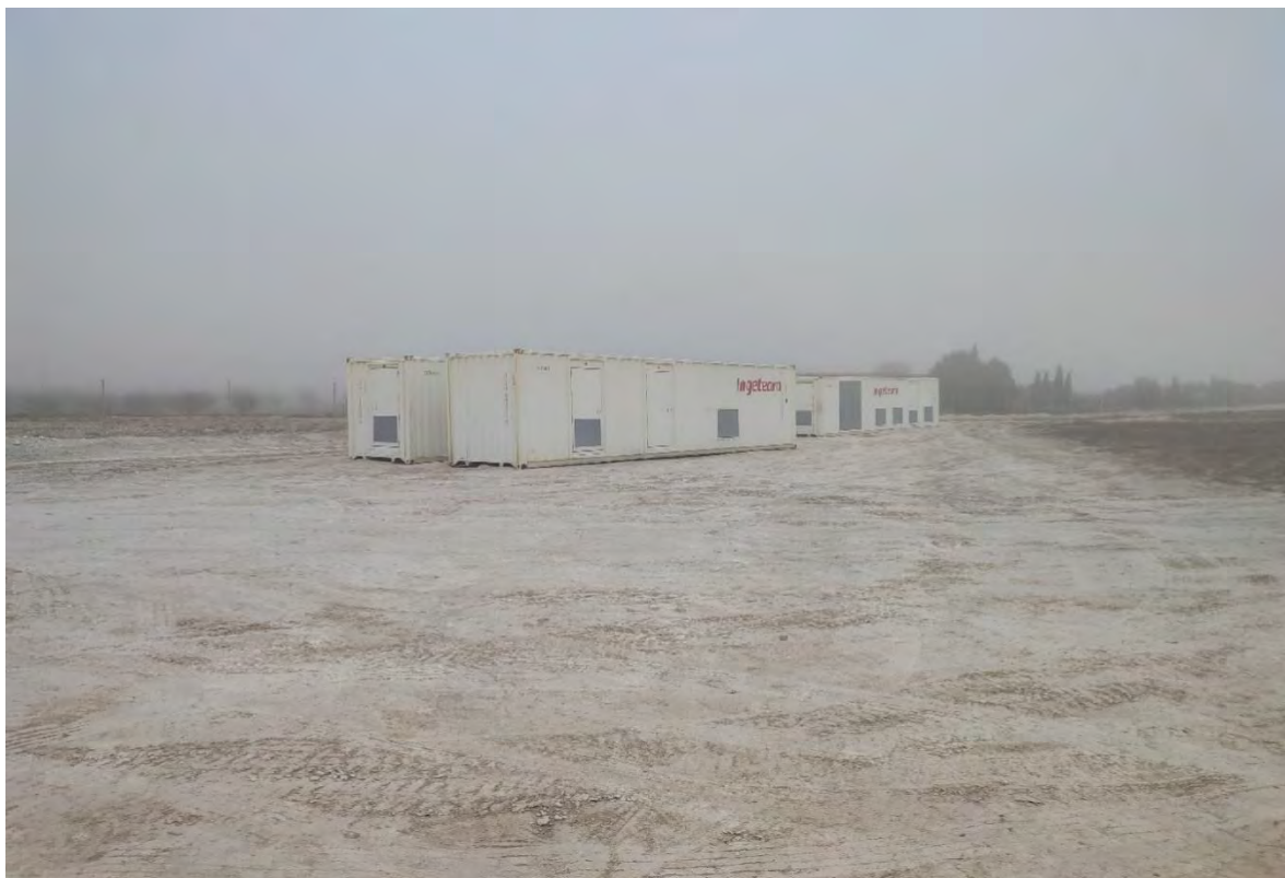
Fotografía 7. Zona de casetas de obra.
