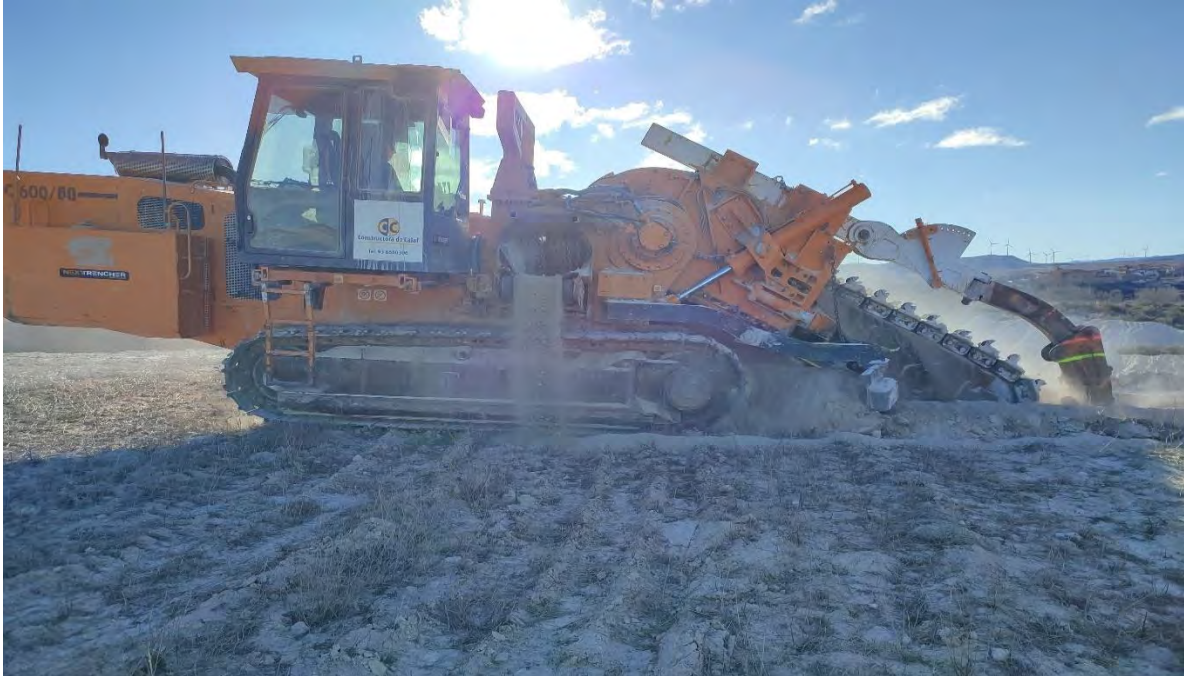
Fotografía 3. Apertura de zanjas con zanjadora.
