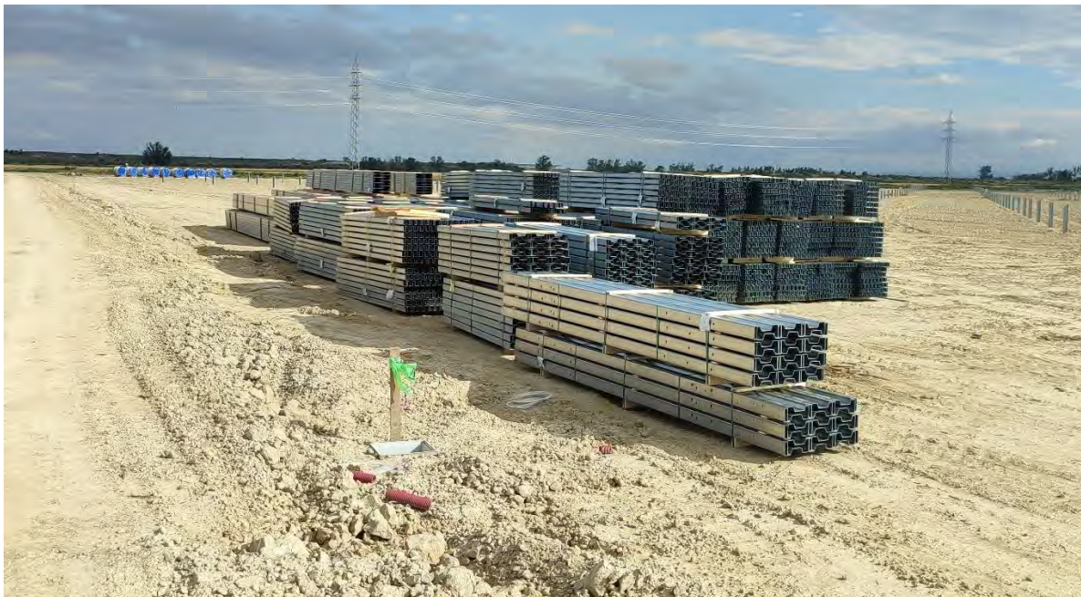
Ilustración 2. Jalonamiento zona de acopio.
