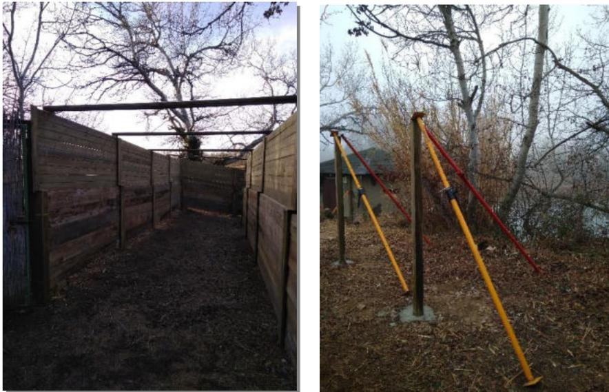
Fotos 19 y 20. Instalación de barrera visual en el observatorio.
