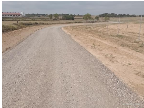
Fig. 1 Corte del antiguo camino y apertura del nuevo camino.
