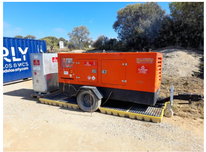
Fig. 1. Grupo electrógeno y contenedor de aceites y combustibles sobre cubeto de retención.
