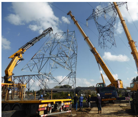
Ilustración 20. Montaje e izado de los apoyos
