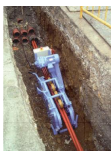
Ilustración 29. Perro tiracables
