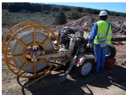
Ilustración 28. Detalle máquina de tiro y entrada de cable en zanja
