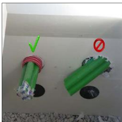
Ilustración 24. Detalle entrada tubos telecomunicaciones
