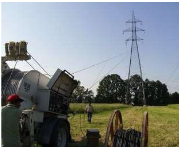
Ilustración 21. Tendido del cableado eléctrico mediante máquina de tracción
