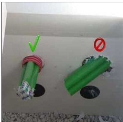
Ilustración 24. Detalle entrada tubos telecomunicaciones
