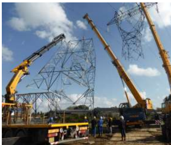
Ilustración 20. Montaje e izado de los apoyos
