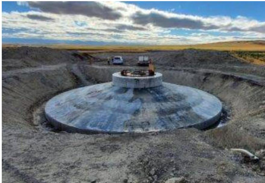
*Imagen de cimentación tipo de Aerogenerador*
