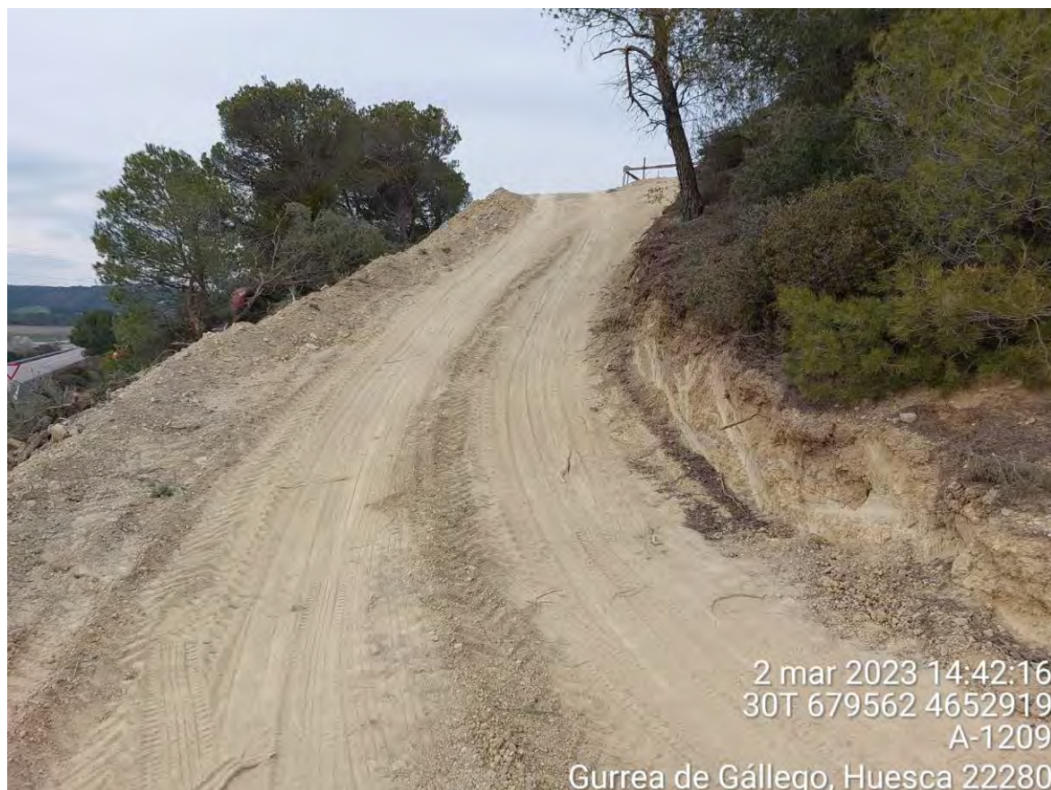
Imagen 3. Acceso al apoyo 50 tras realizar los trabajos de tala y desbroce.
