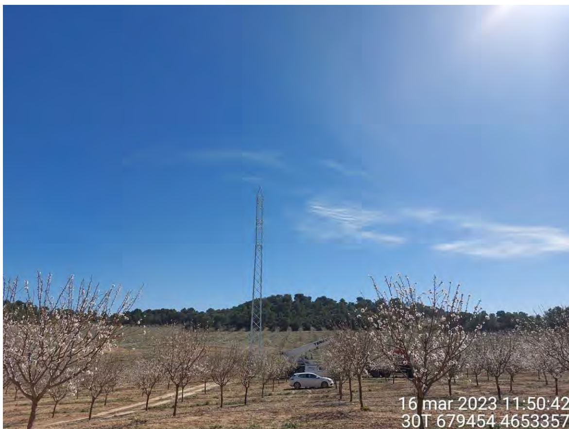
Imagen 1. Apoyo 48 en montaje.
