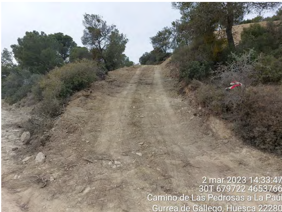
Imagen 2. Entrada al apoyo 46 tras realizar los trabajos de tala y desbroce.
