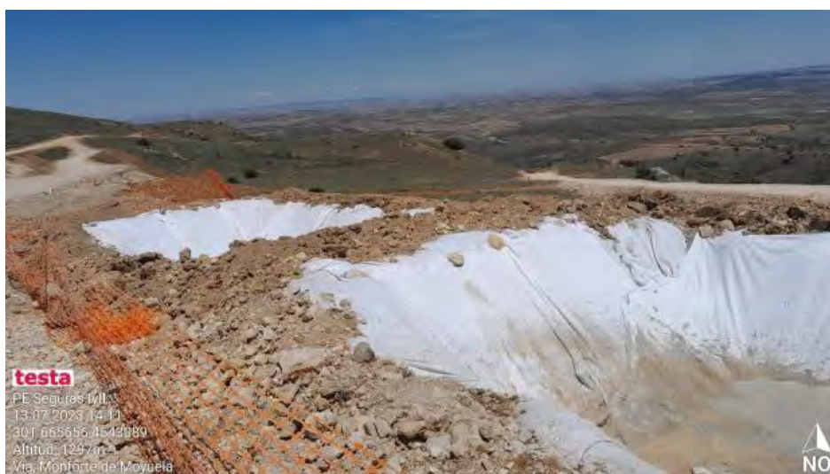
Nuevo pozo de lavado en SE2-2.
