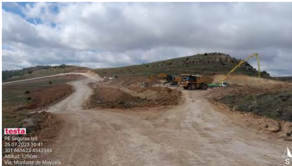
Afección por vial inadecuado con NC en SE2-3.
