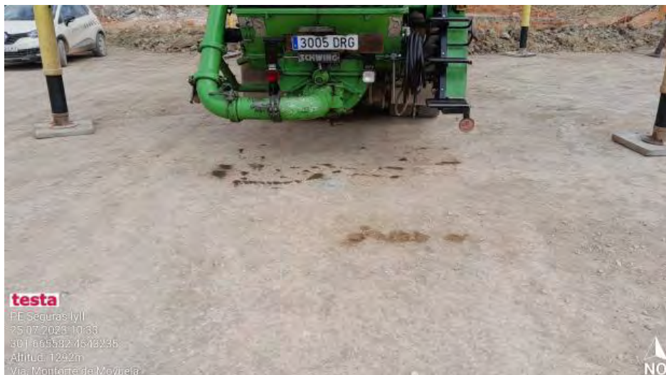
Manchas de bomba en SE2-3
