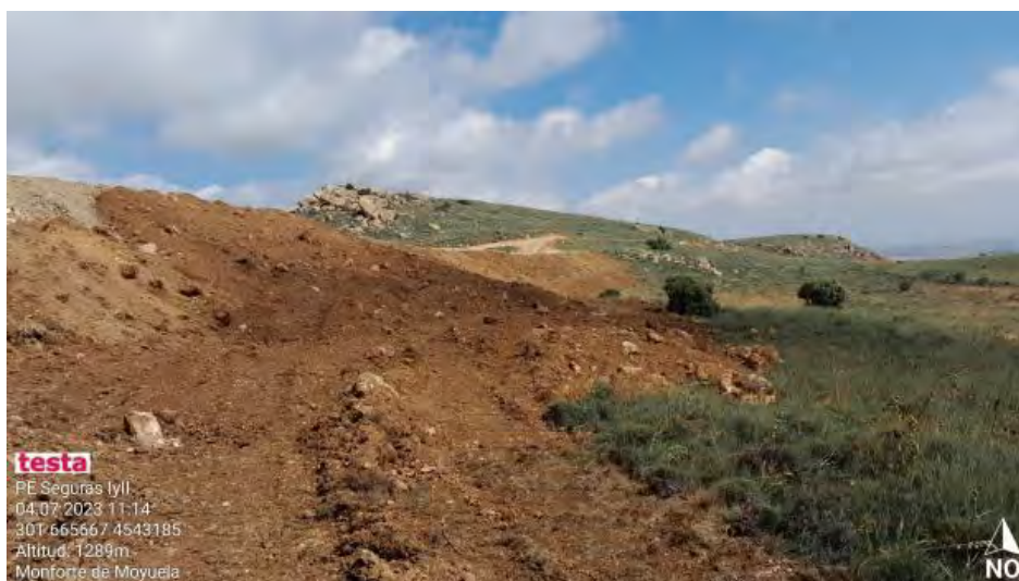
Extendido de tierra vegetal en SE2-3
