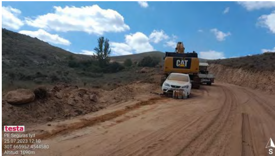
Derrame por avería en anillo norte.
