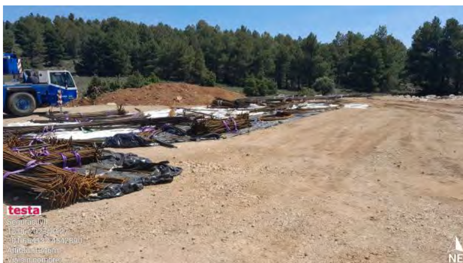
Ferralla con manta de protección de suelos.
