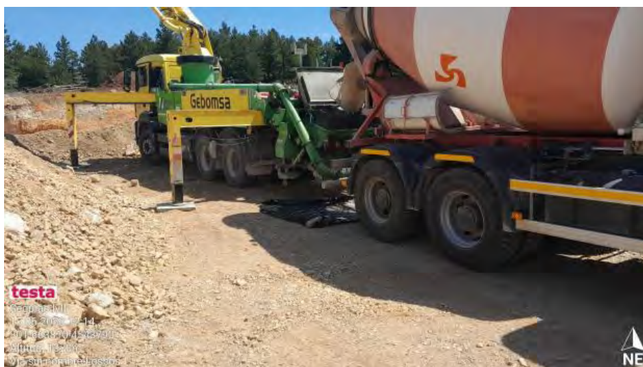
Hormigonado en SE1-1 con protección de suelo en bomba.
