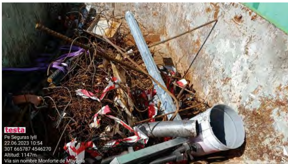
Mezcla de residuos en contenedor RNP en punto limpio.
