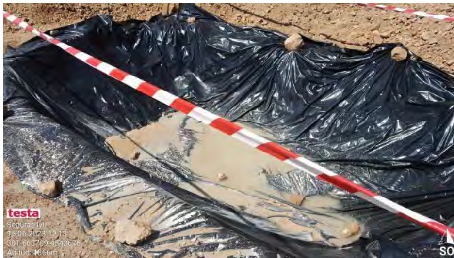
Pozo de lavado en SE1-1
