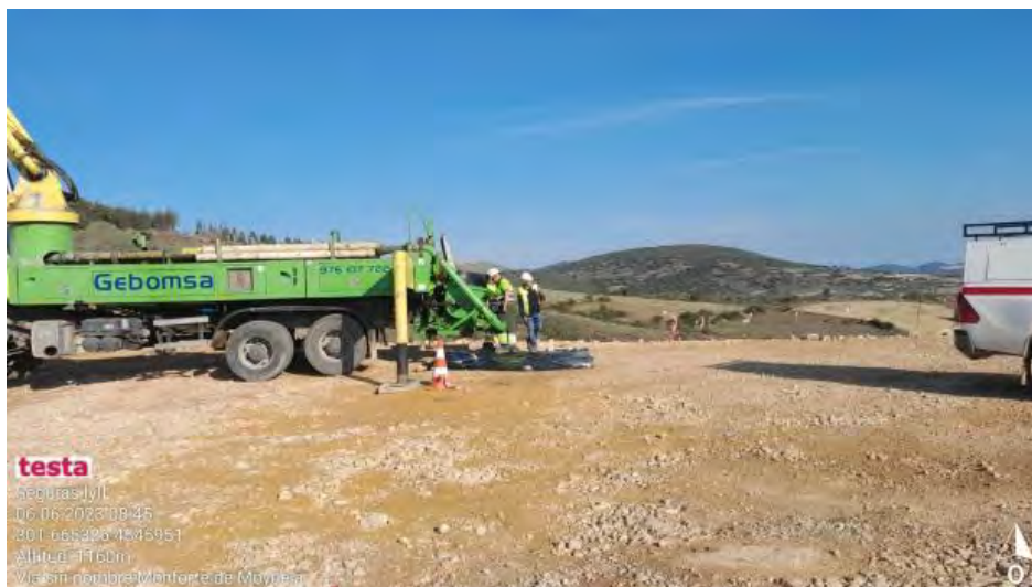
Aislamiento para derrames en bomba.
