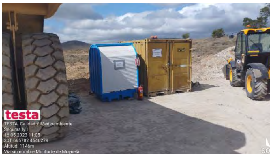
Contenedor Abadía aún en obra
