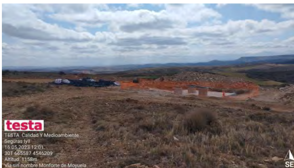
Torre meteorológica sin pozo de lavado
