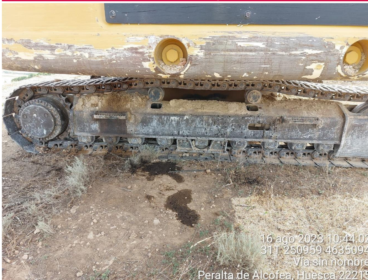
Imagen 1. No conformidad leve. Mancha de aceite por trabajos de reparación de maquinaria sin protección del suelo.
