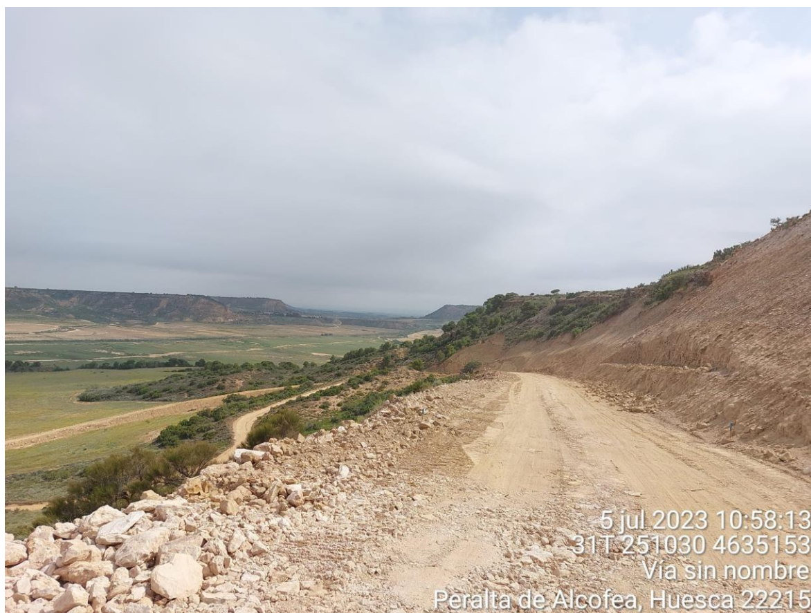
Imagen 2. Tramo del vial entre SET y SC1. Vial que se debe regar.
