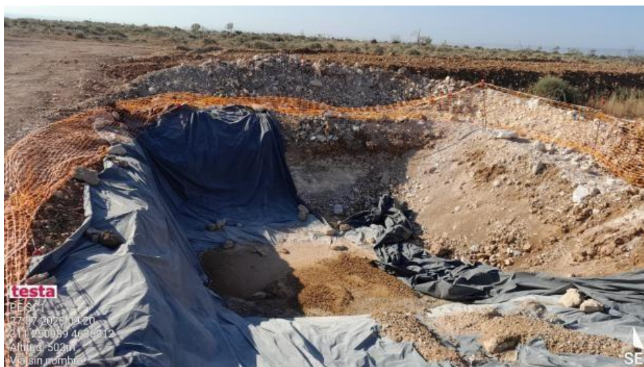
Pozo de lavado en SC1-1
