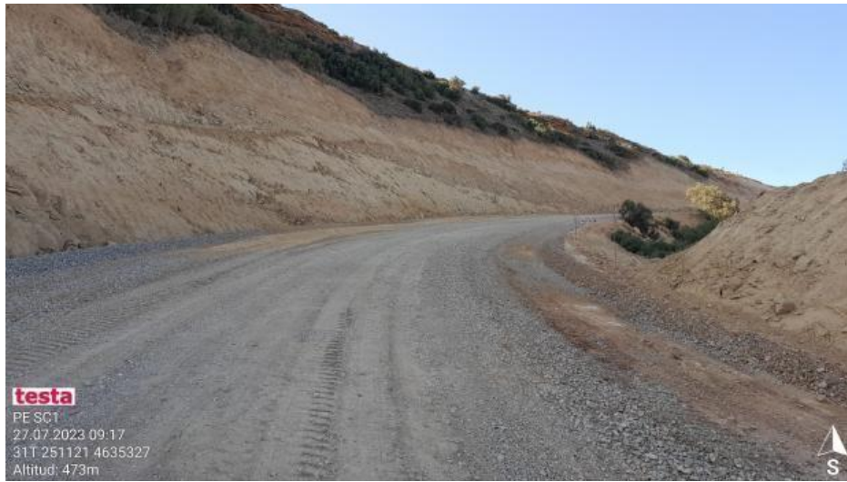
Adecuación del vial de subida a SC1
