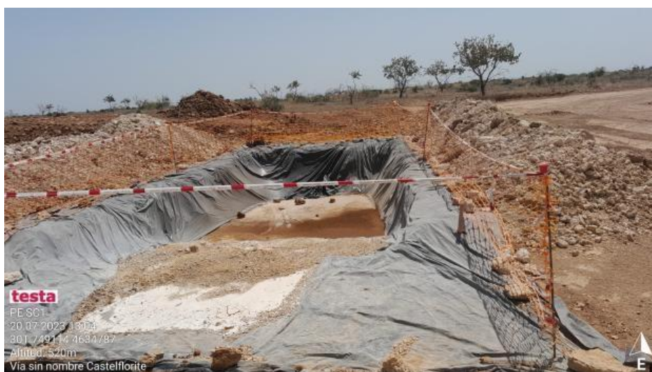
Adecuación de pozos de lavado en SC1
