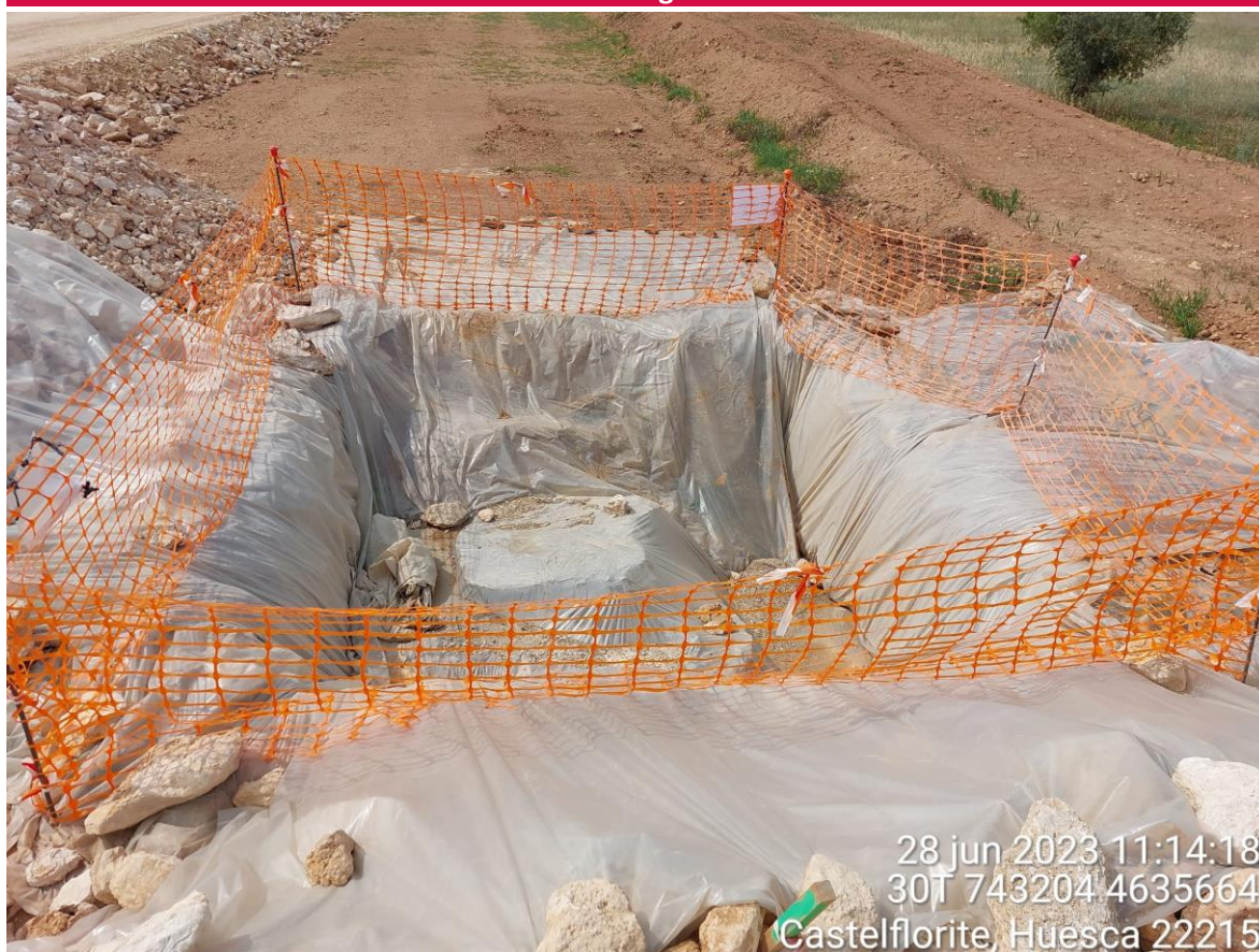
Imagen 2. Pozo de lavado en SC2-01 apto para ser utilizado en el hormigonado de mañana.
