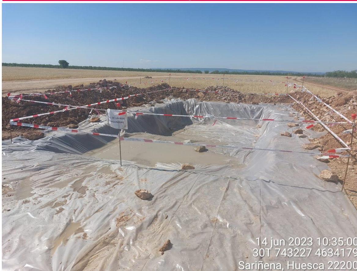
Imagen 1. Pozo de lavado en SCA-01 en buenas condiciones.
