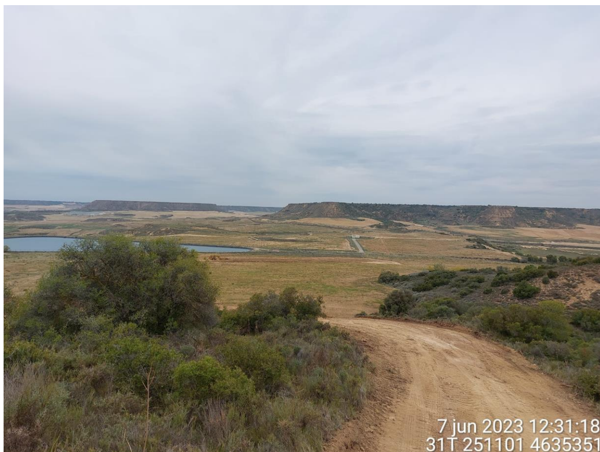
Imagen 2. Desbroce en el vial de SC1 conflictivo.
