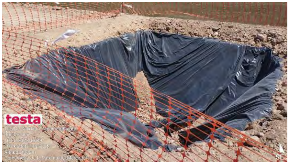
Nuevos pozos en avance de obra correctos
