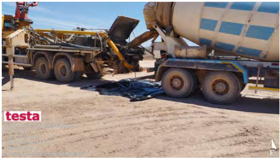
Descarga de hormigón correcta
