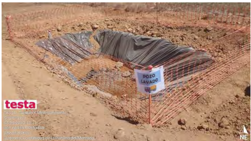
Nuevo pozo de lavado bien acondicionado
