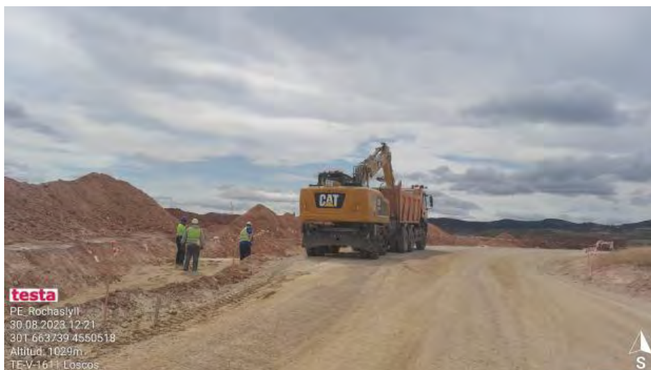
Extendido de cable en zanja de evacuación.
