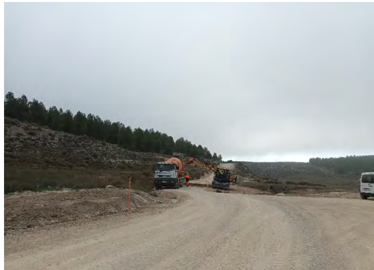
Figura 1: Hormigonado paso al vial principal
