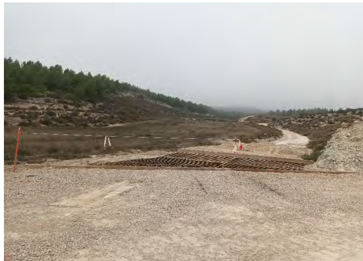
Figura 2: Zona pendiente de hormigonar
