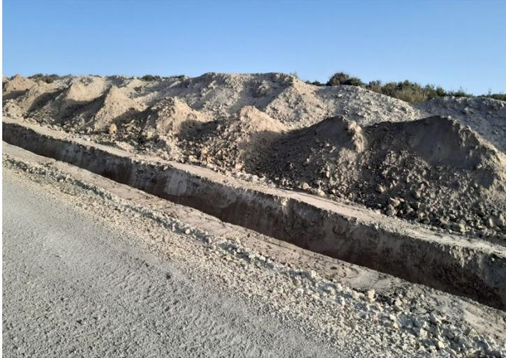
*Figura 1: Separación de tierras apertura zanja MT*
