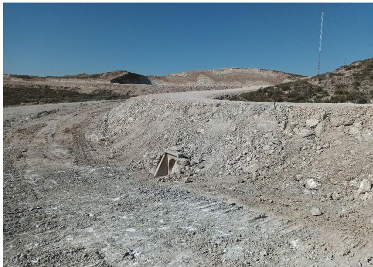
*Figura 2: ODT Vial acceso a torre medición autosoportada*
