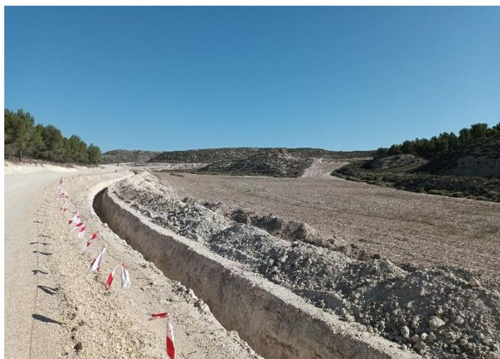
*Figura 2: Separación de tierras apertura zanja MT*
