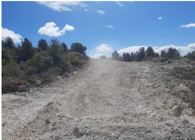
Figura 1: Desbroces en el acceso a CAM-04.
