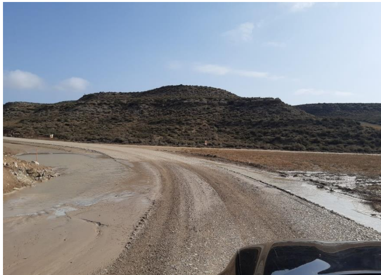
Figura 1: Inundaciones en zona de vaguada vial acceso CAM-12.
