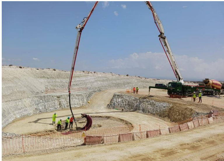
Figura 1: Hormigón de limpieza en la base de CAM-03.
