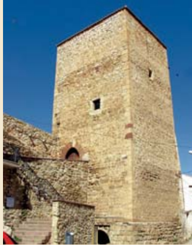
Torre de «La Cárcel» de Ojos Negros
