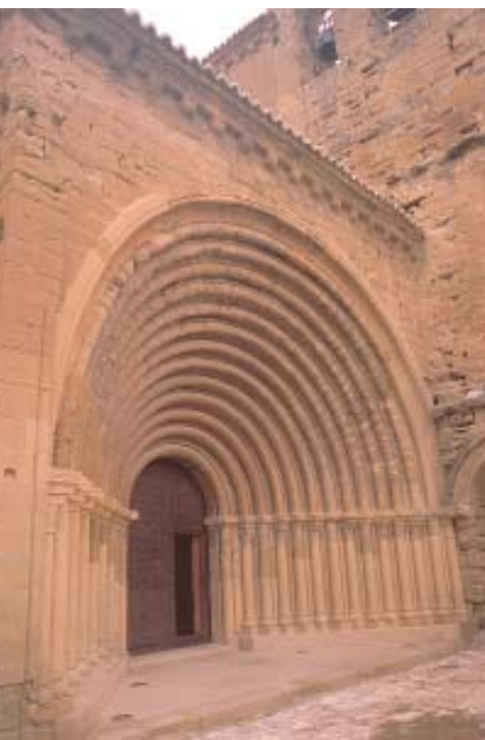
Magnífica portada románica que da acceso a la iglesia del monasterio
