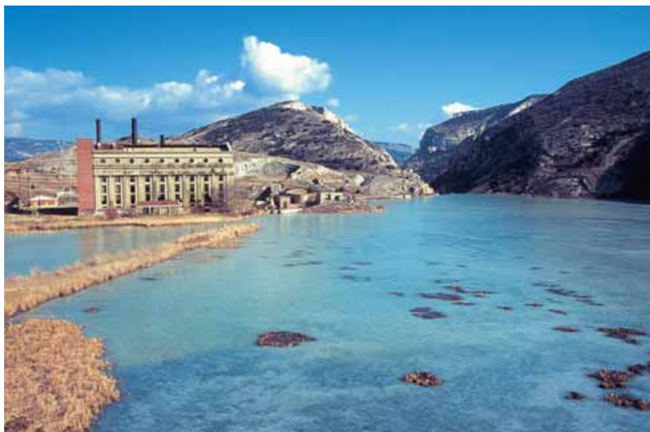
Central térmica en desuso de Aliaga
