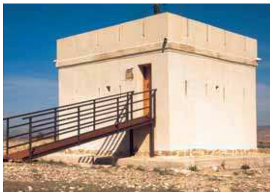
Torre óptica de Chiprana
