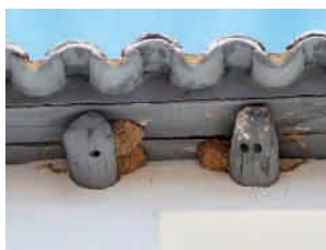
María de Huerva. Alero de vigas de madera
