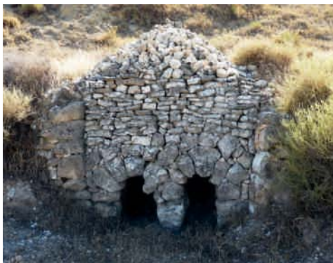
Horno de yeso. Torrecilla de Valmadrid
