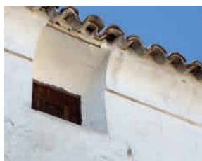
Torrecilla de Valmadrid. Alero de “media caña”
