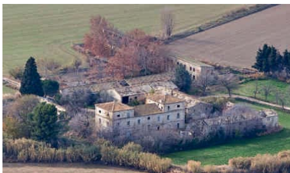
Movera. La monumental Torre Morlans (mediados del s. XIX), con su cortejo de almacenes, granja y viviendas de colonos en proceso de ruina
