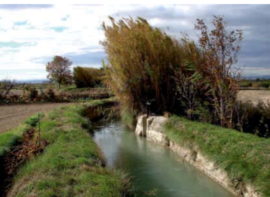
Término regante de Villamayor. Acequia de la Val, en la partida del Temblar, con cajero elevado
