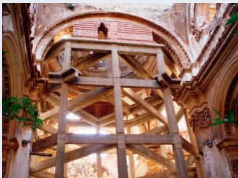
Estructura de apeo de la cúpula
