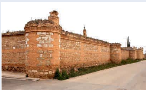
La notable cerca exterior, con llamativo aparejo de yeso alabastrino
