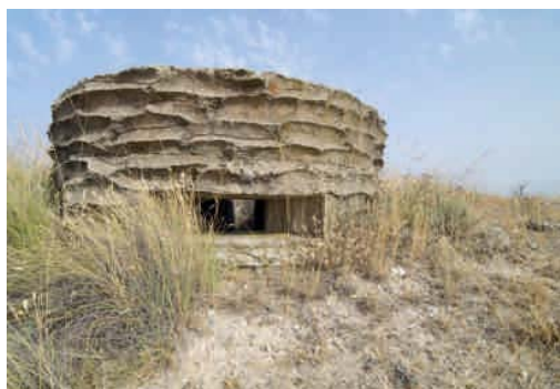
Búnker en el vértice Flora (monte de la Pica, Villamayor)
