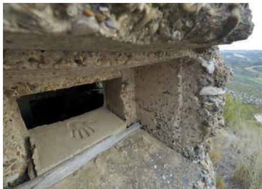
Tronera de un búnker en la posición Primoral (monte de Alfajarín). Obsérvese la mano impresa en el hormigón de la tronera
