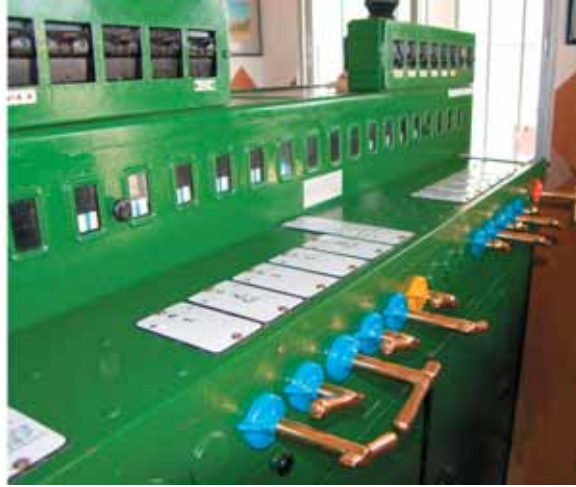
Mesa de enclavamiento de Cariñena
