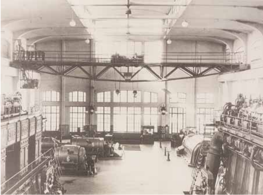
Centrale montemartini, interno della Sala Macchine, 1946
