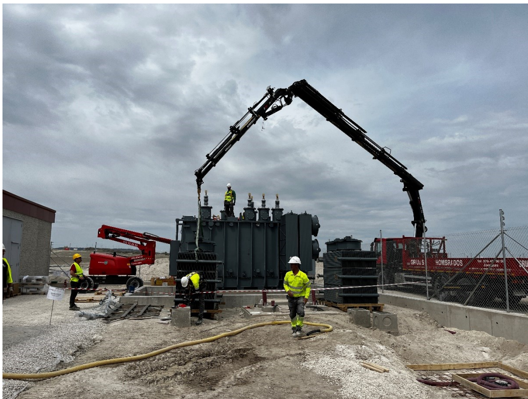
Figura 11 Trabajos de la SET
