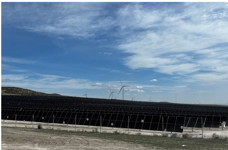
Figura 6 Montaje de los módulos fotovoltaicos
