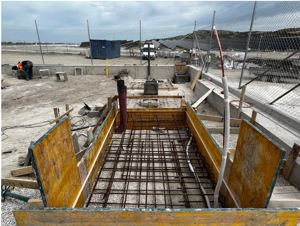
Figura 10 Trabajos de la SET
