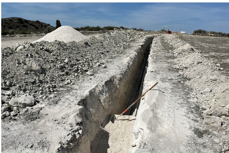
Figura 7 Cableado de las zanjas de la línea de evacuación
