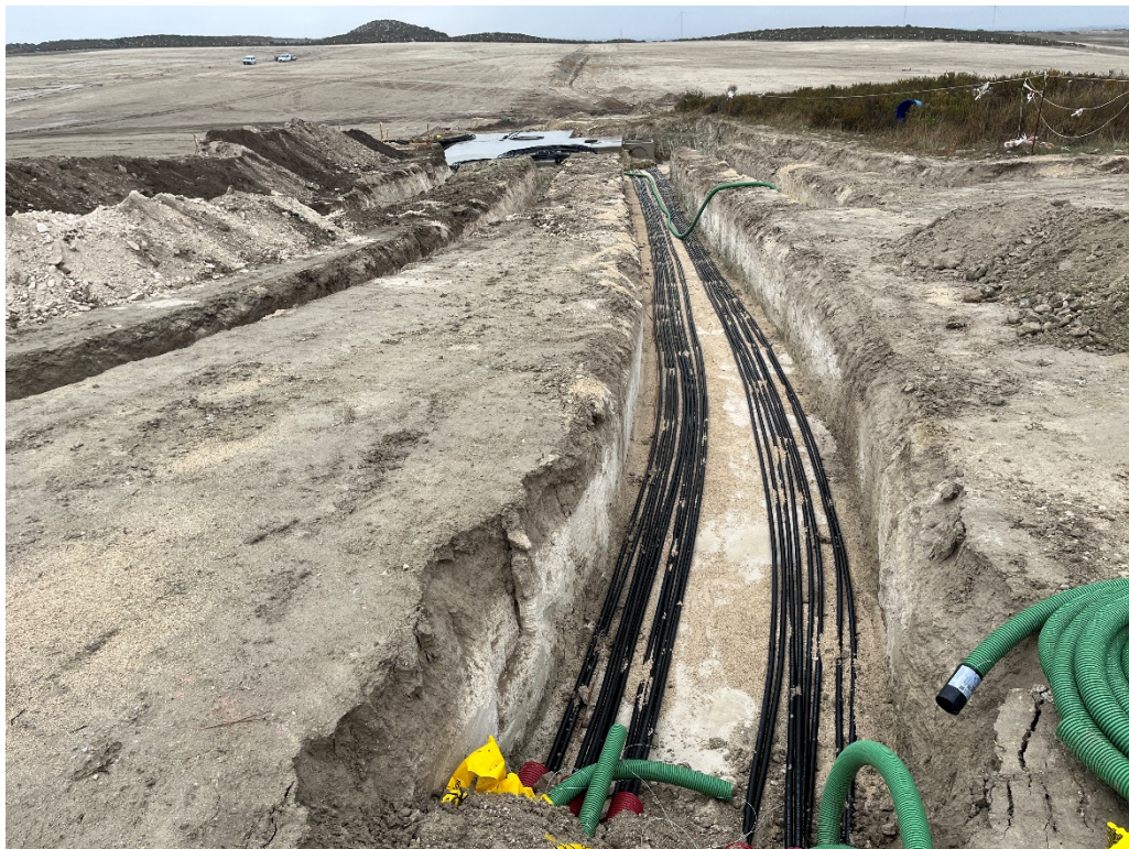
Figura 11 Cableado de las zanjas
