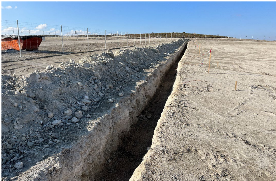
Figura 7 Apertura de zanjas
