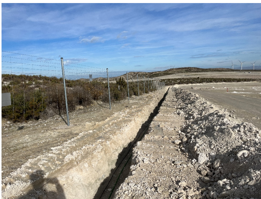
Figura 2 Apertura de zanjas
