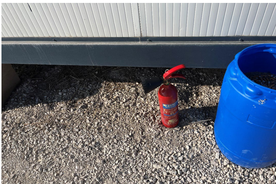
Figura 8 Extintores en obra
