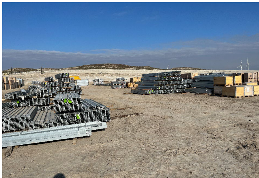
Figura 5 Zona de acopio de material de construcción
