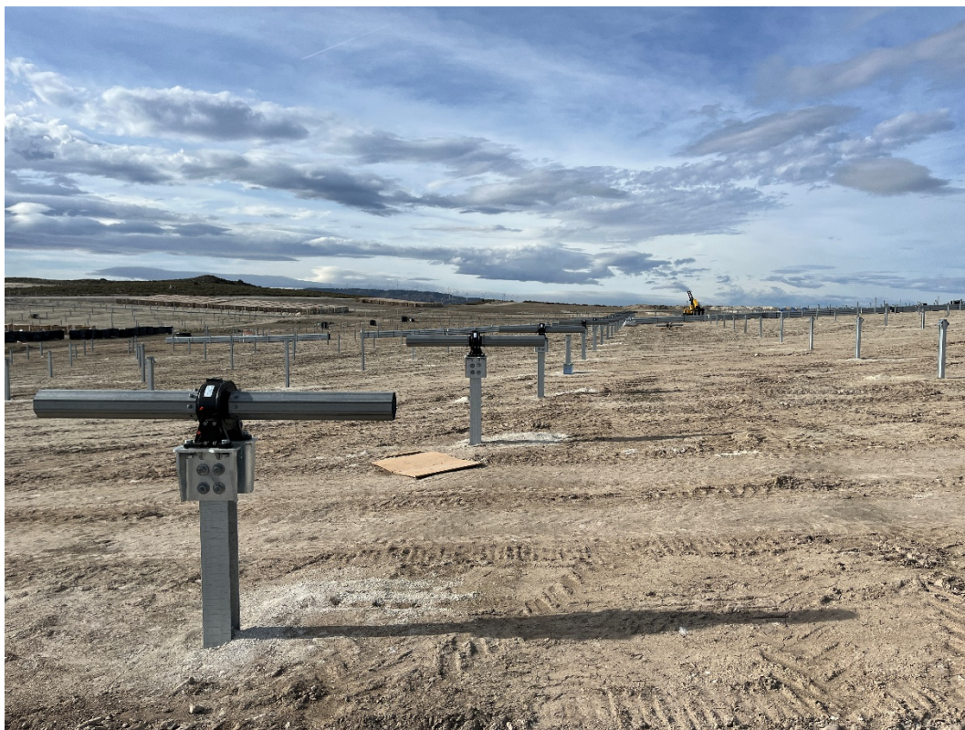
Figura 12 Montaje de las tomas de fuerza
