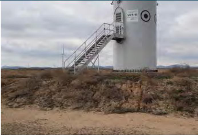
Fig. 1 Erosión hídrica en materiales lutíticos de la cimentación del aero VR1.11. Fuente: Elaboración propia
