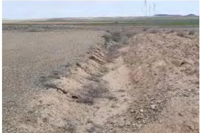
Fig. 4 Erosión hídrica en materiales lutíticos del talud de desmonte de plataforma del aero VR1.10. Fuente: Elaboración propia
