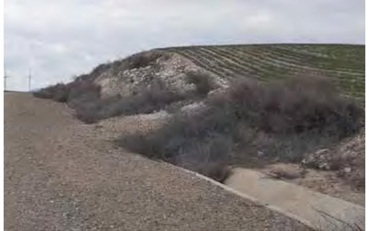
Fig. 2 Cuneta y tubo de drenaje taponado por vegetación arbustiva en vial de acceso al aero VR1.07. Fuente: Elaboración propia
