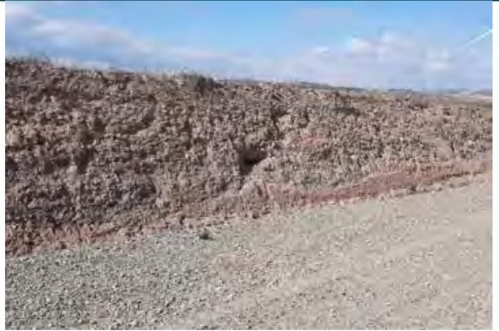
Fig. 2 Erosión hídrica en materiales lutíticos del talud de desmonte del vial de acceso al aero VR1.05. Fuente: Elaboración propia
