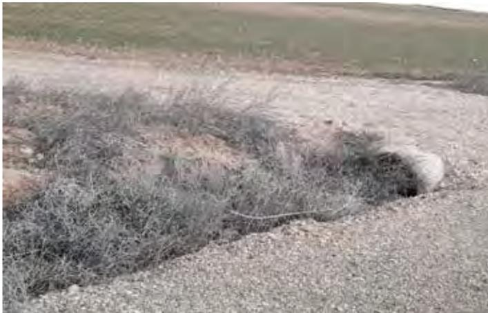
Fig. 3 Tubo de drenaje semitaponado con vegetación arbustiva y sedimentos en vial de acceso al aero VR1.06. Fuente: Elaboración propia
