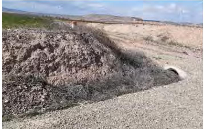
Fig. 4 Tubo de drenaje taponado por vegetación arbustiva en vial de acceso al aero VR1.05. Fuente: Elaboración propia
