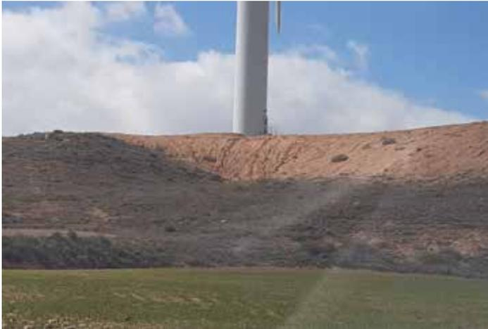
Fig. 3 Erosión hídrica en materiales lutíticos del talud terraplén del aero VR1.12. Fuente: Elaboración propia
