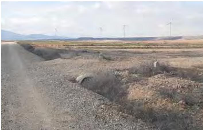
Fig. 5 Tubo de drenaje semitaponado con vegetación arbustiva en vial de acceso al aero VR1.02. Fuente: Elaboración propia
