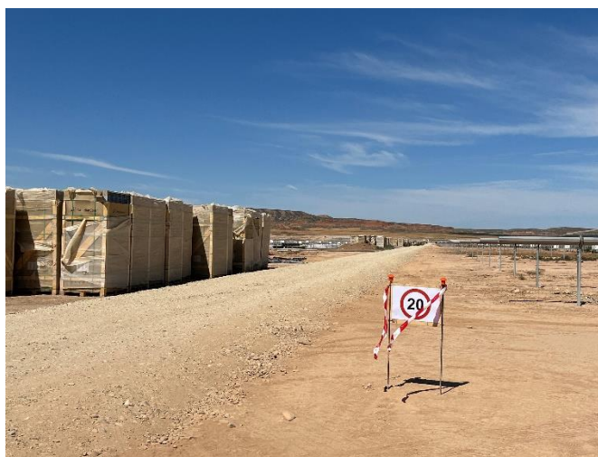
Figura 6 Señalización en obra
