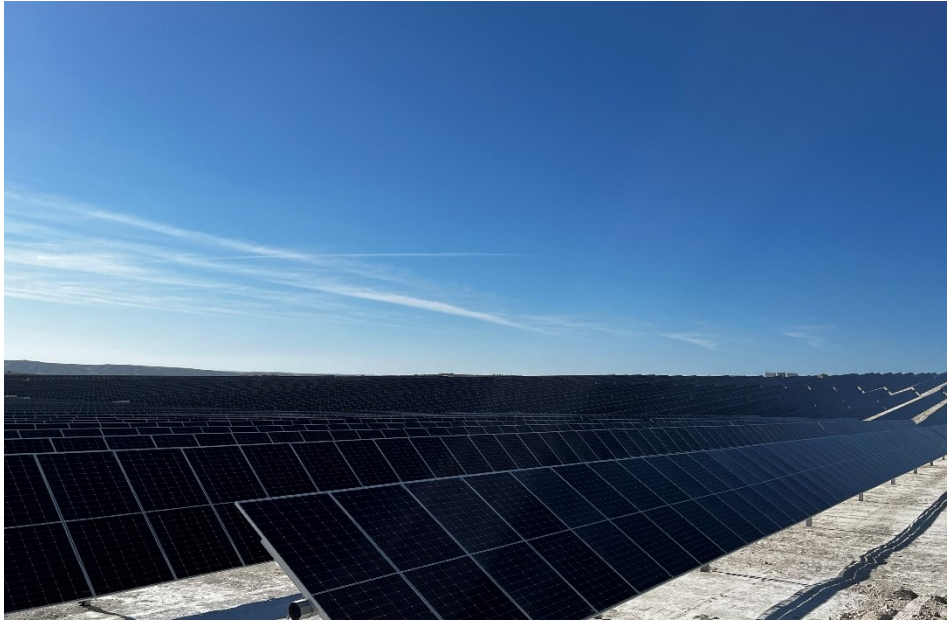
Figura 6 Montaje de los módulos
