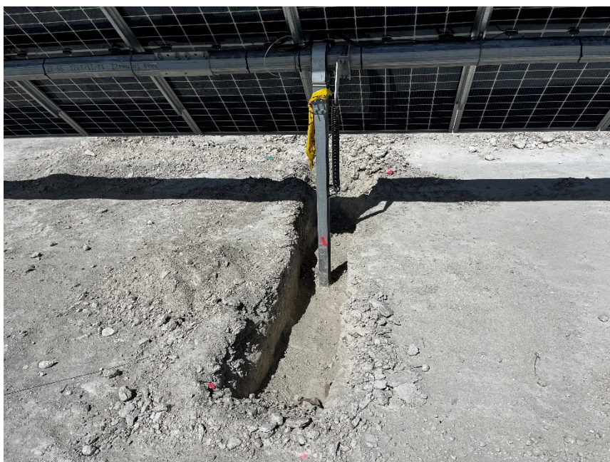
Figura 2 Cimentación de las hincas rechazadas
