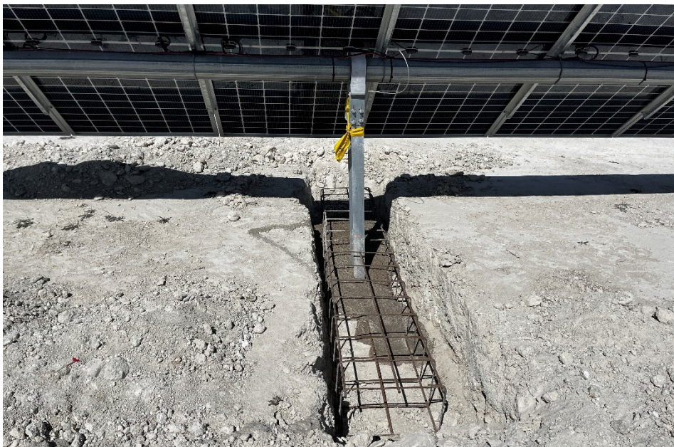
Figura 7 Cimentación de las hincas rechazadas
