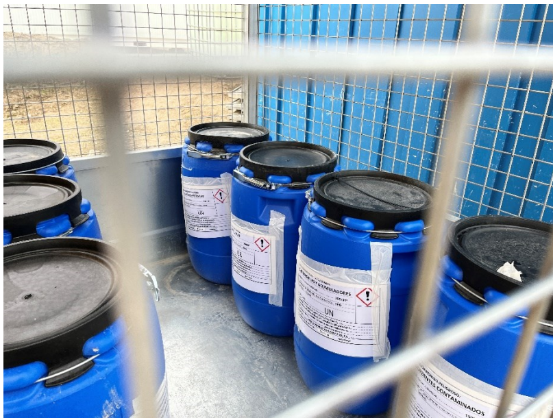
Figura 3 Punto limpio de residuos peligrosos
