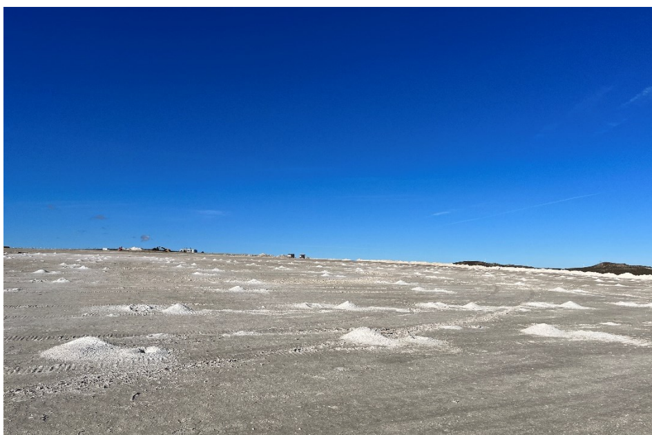
Figura 8 Perforaciones del terreno para el hincado
