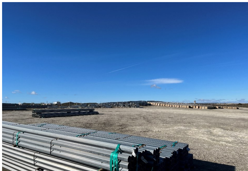
Figura 5 Acopio de material de construcción
