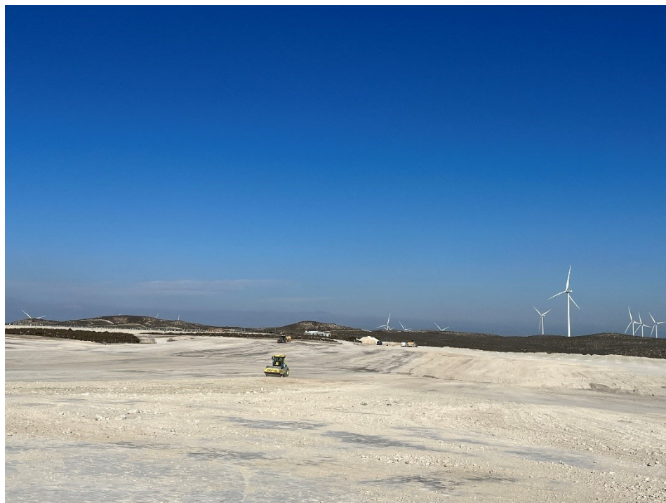
Figura 11 Nivelaciones del terreno
