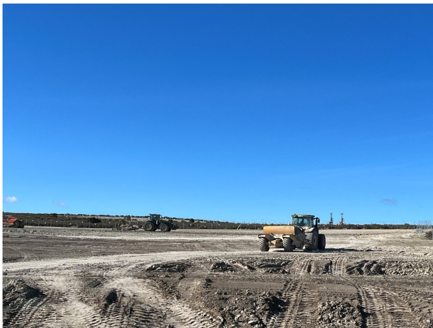
Figura 2 Trabajos de movimiento de tierras
