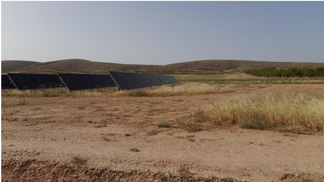
Foto 9. Presencia de cubierta herbácea bajo seguidores. Apreciación de pequeñas manchas de vegetación a lo largo de los caminos
