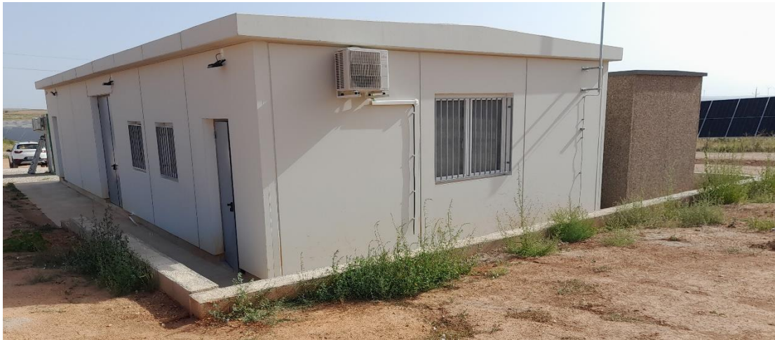
Foto 2. Oficina de O&M finalizada
