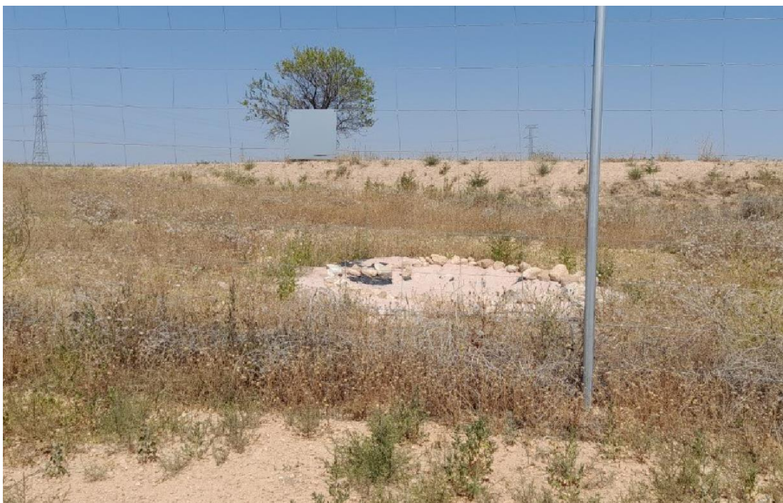
Foto 10. Balsa ejecutada en el perímetro de la planta
