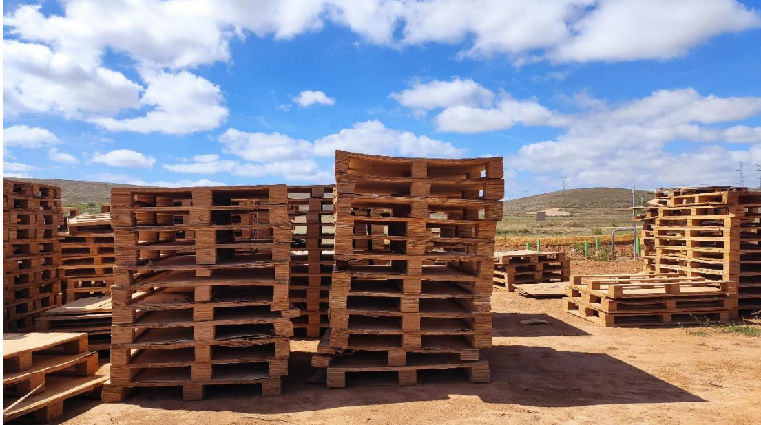
Foto 3. Acopio de RCD's (palets de madera) en zona de obra.
