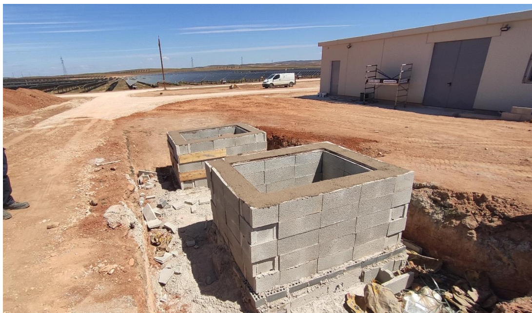
Foto 10. Avance de la construcción del centro de Operación y Montaje de la Planta Fotovoltaica.
