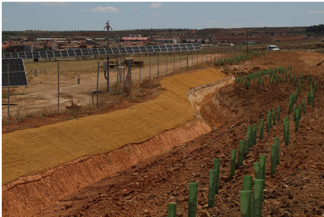
Foto 12. Aspecto de las labores de revegetación: manta orgánica en jarillón de protección de drenaje y banda de plantaciones.
