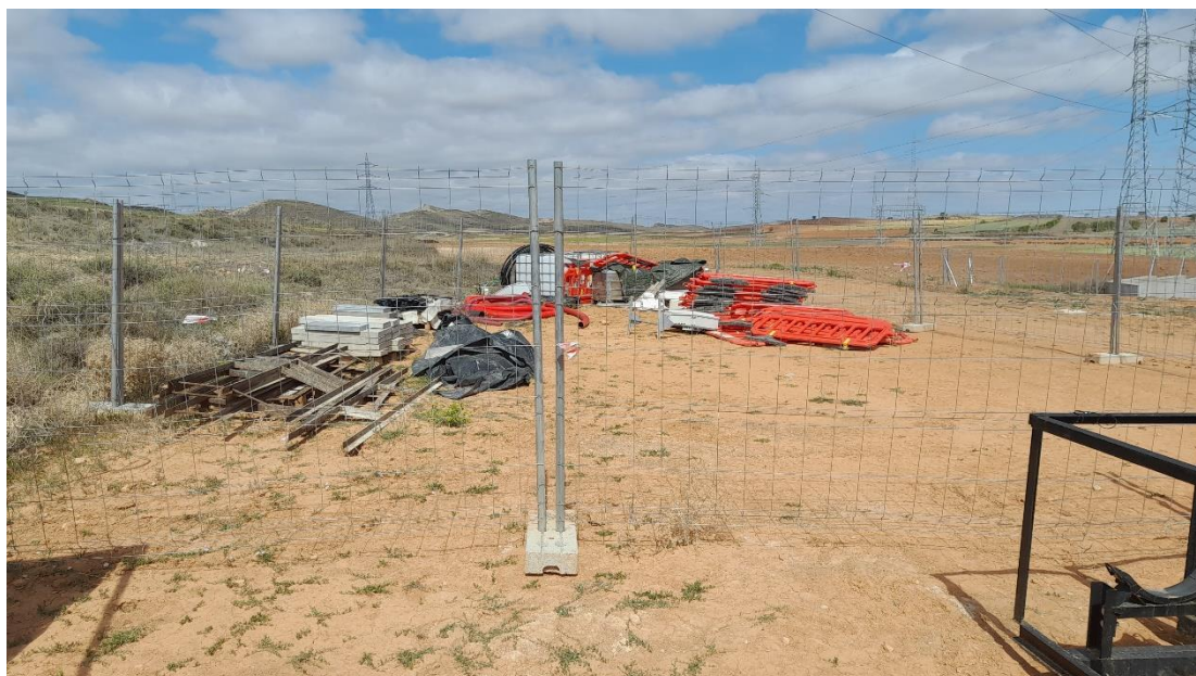
Foto 20. Zona de acopios.
