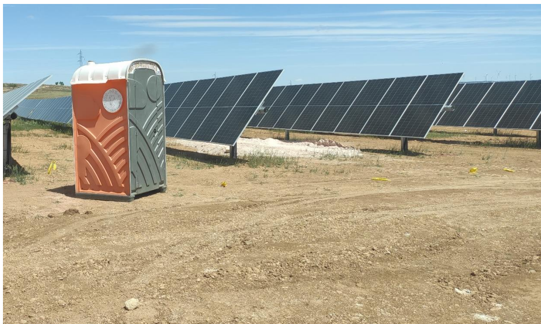
Foto 8. Uno de los baños químicos distribuidos por los tajos
